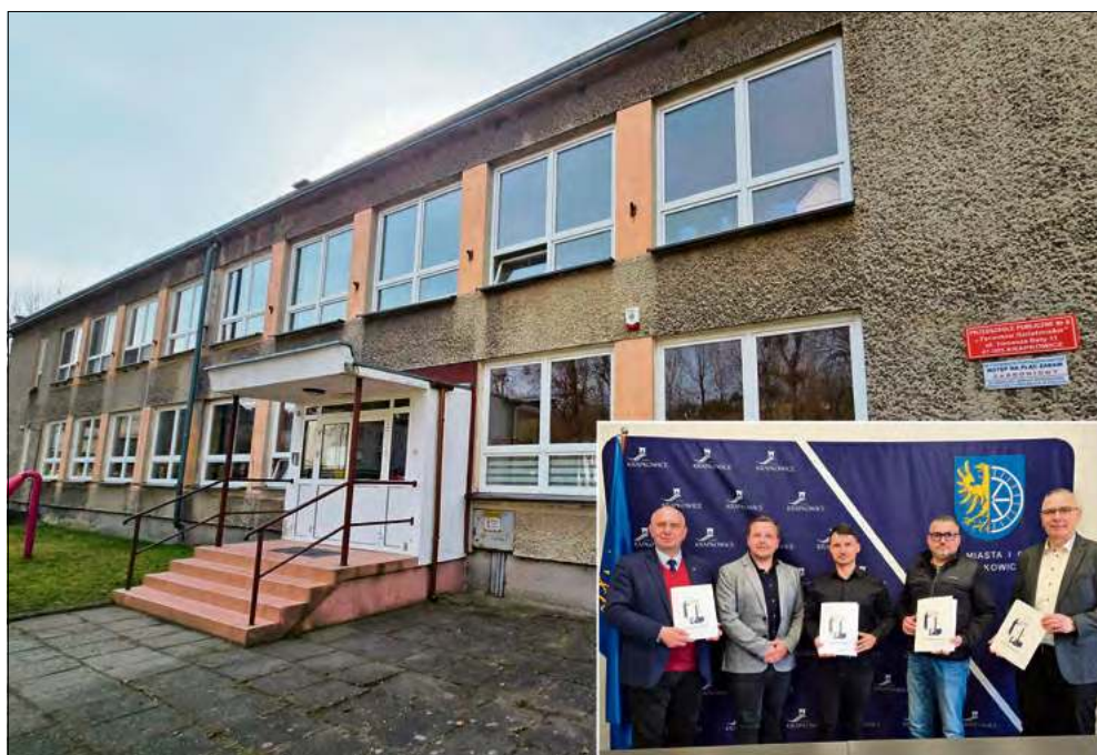
Otmękie przedszkola przejdą gruntowny remont termoizolacyjny.
