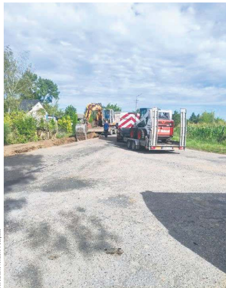
Drogi Powiatu Gostynińskiego zostaną przebudowane i zmodernizowane
