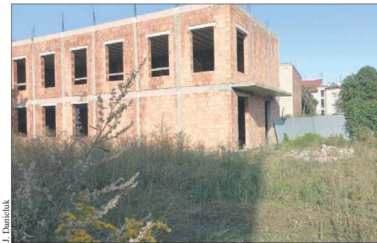
Na takim etapie zakończyły się prace przy budowie nowego skrzydła USC. Teraz jest szansa na dokończenie prac
