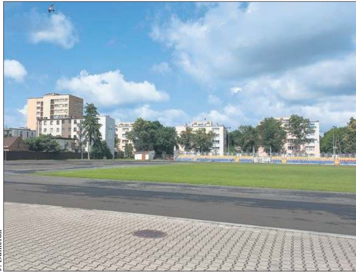
Trwa przebudowa Stadionu Miejskiego im. Bernarda Szymańskiego
