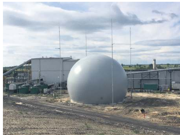
Pożar nie uszkodził żadnej instalacji ZGO i zakład funkcjonuje normalnie. Foto: ZGO
