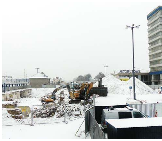
Po dworcu kolejowym nie ma już śladu
