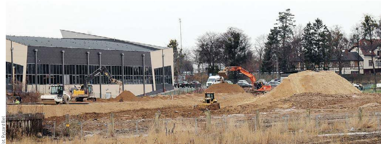
Budowa kąpieliska przy ul. Spacerowej ma zostać ukończona w czerwcu 2025 roku
