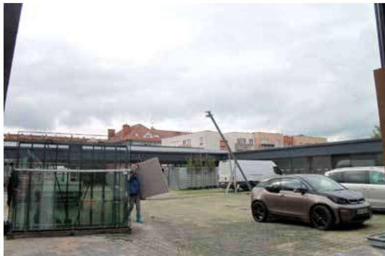
Trwają obecnie prace wykończeniowe
