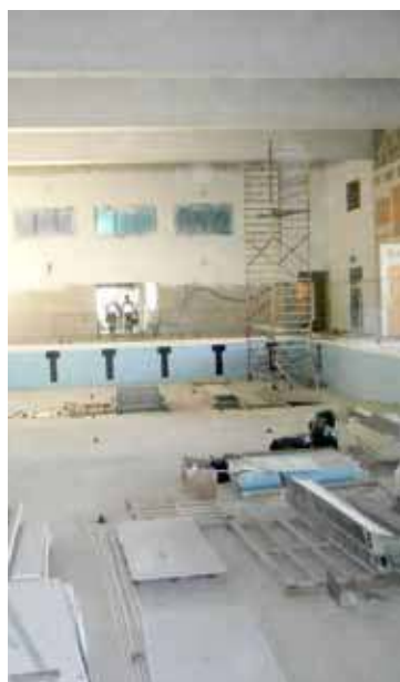
Na basenie podłogę przygotowuje się do położenia glazury
