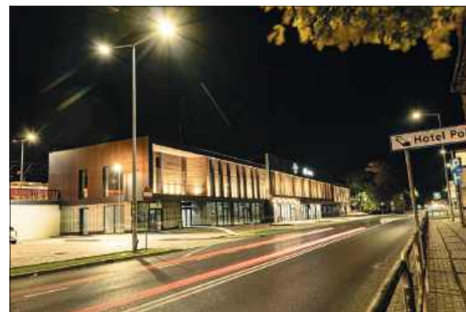
■ Dramatyczny stan techniczny peronów pozostaje w rażącej sprzeczności z wyremontowanym budynkiem dworca – uważa posłanka Gabriela Lenartowicz
