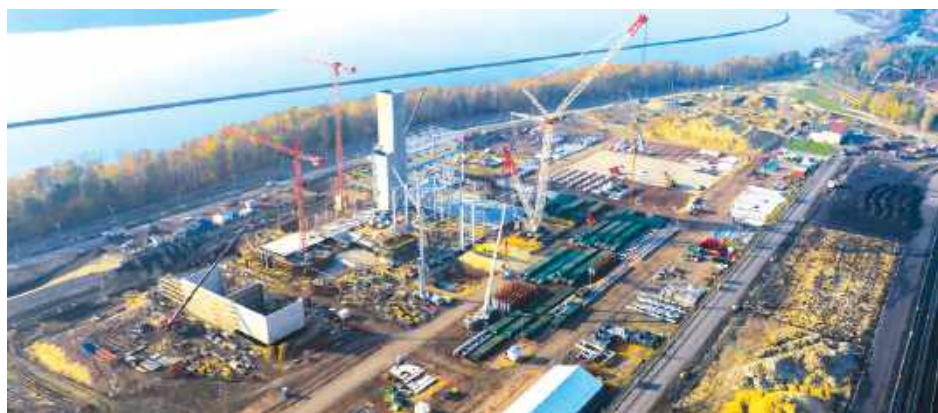
Nowo budowany blok gazowo-parowy w Rybniku
