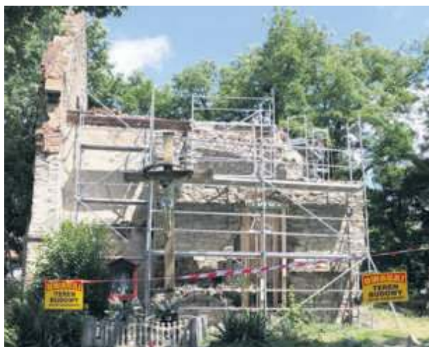
Kilka dni temu rozpoczęły się prace związane z zabezpieczeniem ruin dawnego kościoła ewangelickiego w Miechowicach Oławskich
