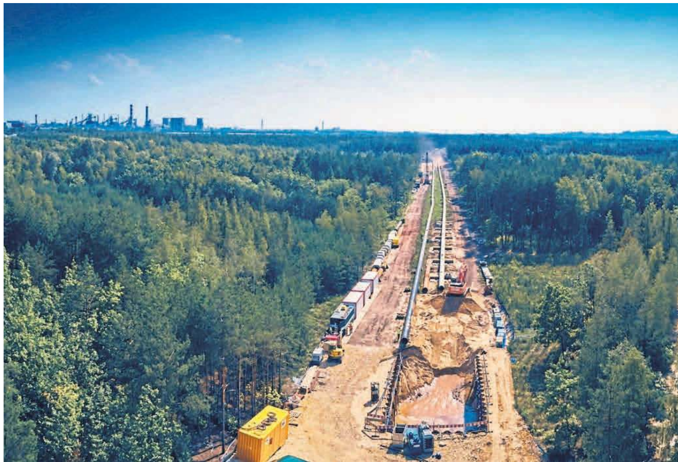
Dopiero z góry widać jaką ogromną inwestycją jest budowa korytarza gazowego Północ - Południe w Dąbrowie Górniczej
