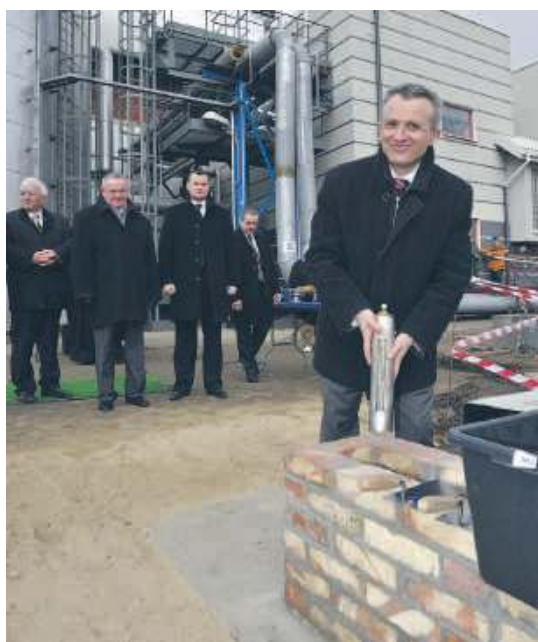
Rok 2011 – wmurowanie kamienia węgielnego pod budowę elektrociepłowni EC2.
