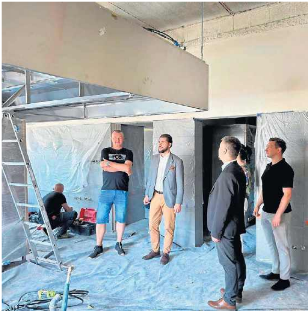
W Skokach powstaje samorządowy żłobek „Skaczące Brzdące”.
