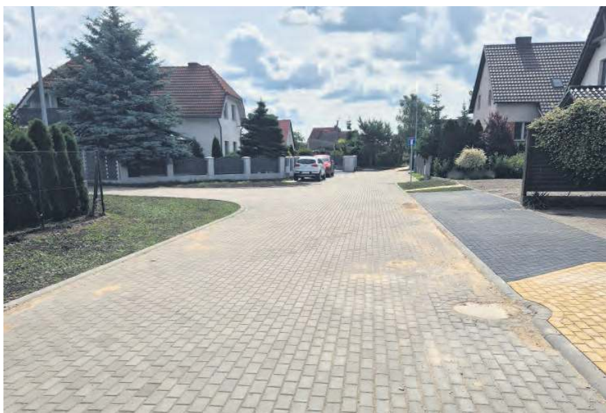
Na zdjęciu skrzyżowanie nowo wybudowanych ulic Jarzębinowej z Akacyjową.
