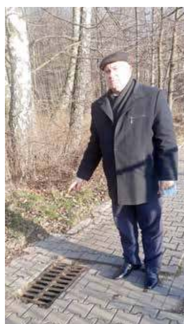
Wykonano studzienki i woda spływa do lasu - mówi wójt.
