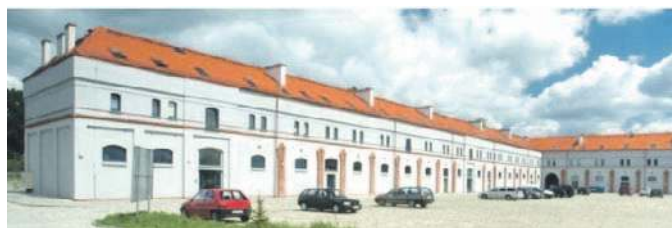
Przebudowa mienia powojkowego w postaci zabytkowych stajni i ujeżdżalni przy ul. 3 Maja w Oławie
