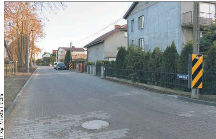
Zakończył się pierwszy etap budowy ulicy Wiejskiej
