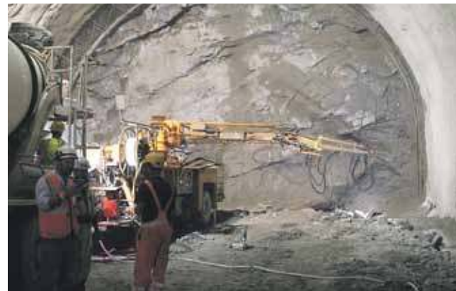
Początek tunelu od południowej strony Małego Lubonia.
