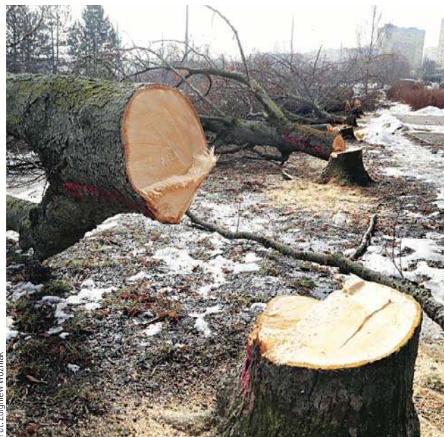
Wycinka drzew pod rozbudowę linii tramwajowej
