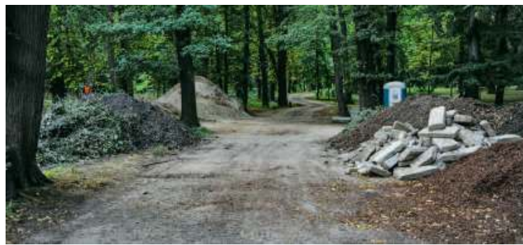
W parku trwają intensywne prace, ale mieszkańcy chcieliby już widzieć efekty tej drogiej inwestycji | fot. Janusz Wolniak/Gazeta Polska
