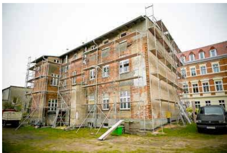
Elewacja kamienicy przy Młyńskiej.jpg
