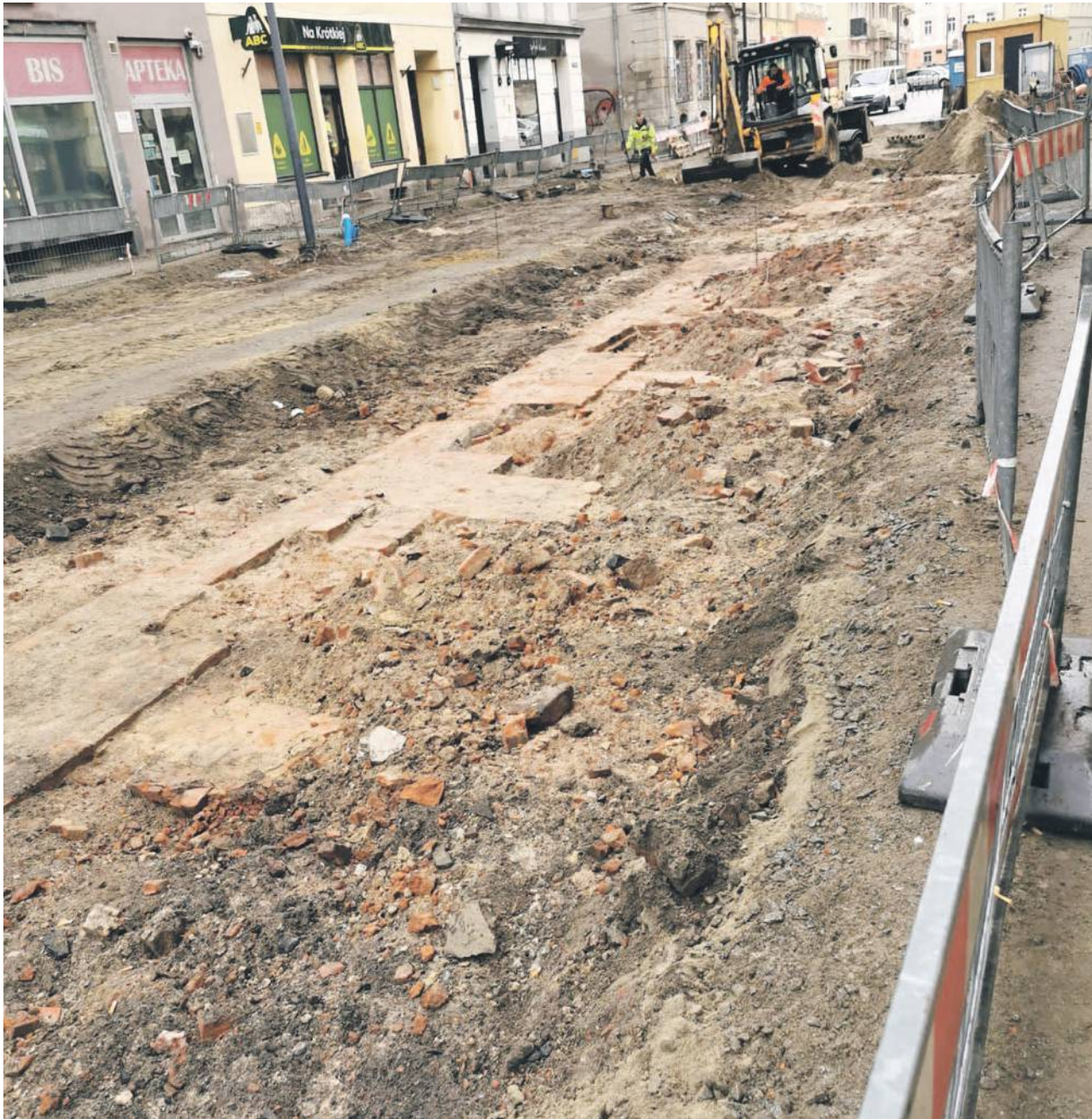
Odkopano fundamenty z drugiej połowy XVIII wieku. Pokazują, jak wąska to była kiedyś ulica
