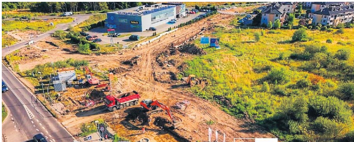
Skrzyżowanie ul. Szosa Polska z Trasą Północną i ul. Policką. W tym miejscu powstanie zespół rond
