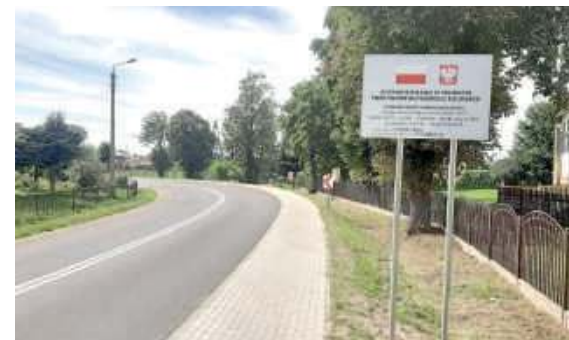
Przebudowana droga powiatowa nr 1557 L na odcinku Serniki - Wola Sernicka
