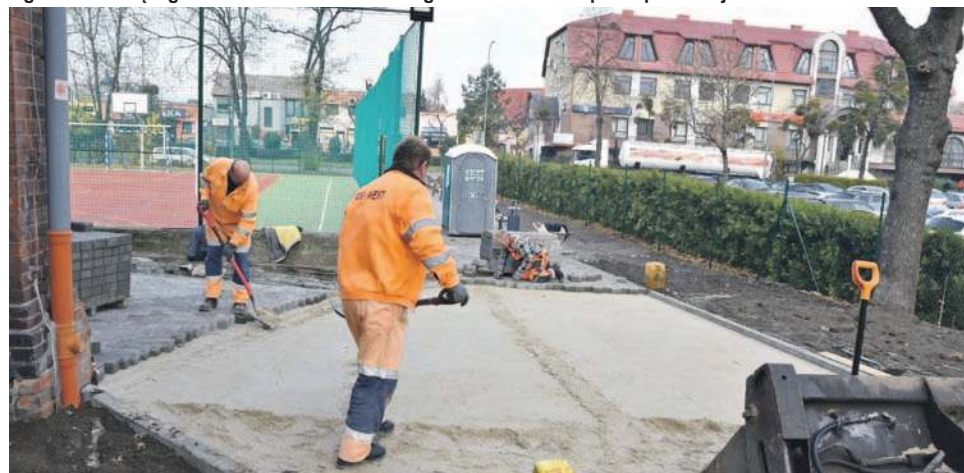
Na finiszu jest już budowa ciągu komunikacyjnego, prowadzącego do zmodernizowanego boiska obok sali gimnastycznej LO
