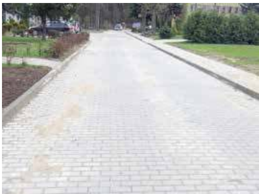
Droga już gotowa
