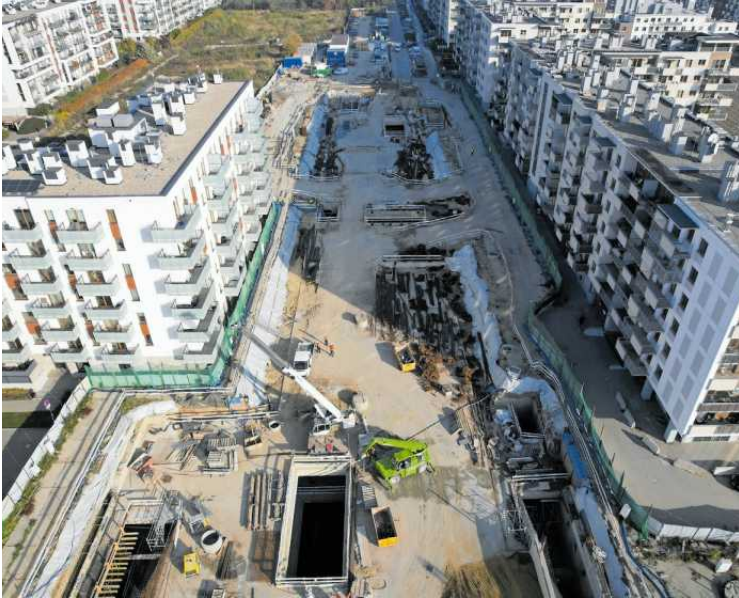
• Plac budowy stacji metra Chrzanów
