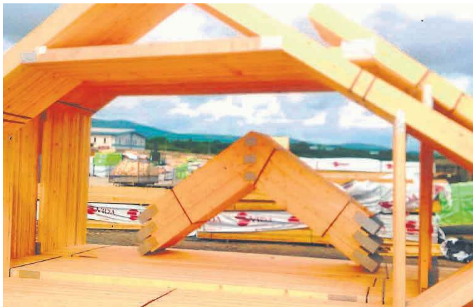
Wiązary dachowe z drewna klejonego przestrzennie mają szerokie zastosowanie
