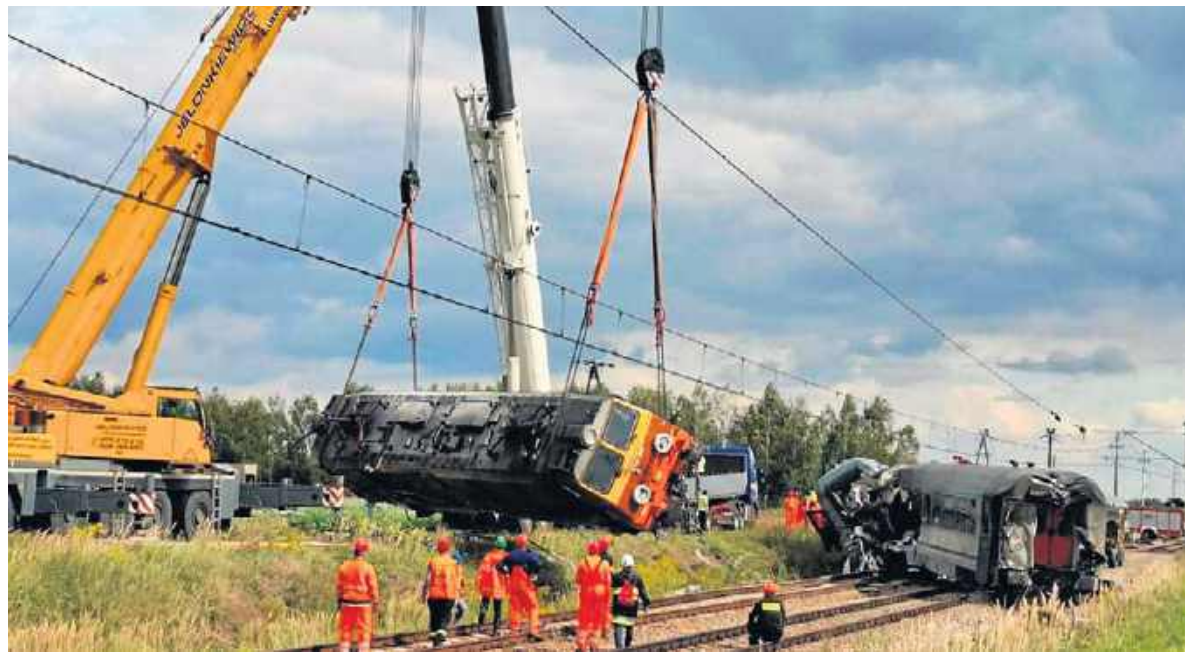
Dwa potężne dźwigi podniosły lokomotywę, która wykoleiła się w wypadku, do którego doszło w Sokolnikach Suchych.
