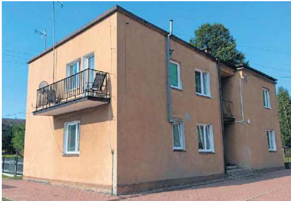
„Dom Nauczyciela” w Mącholicach Kapitulnych przejdzie kompleksową termomodernizację. Gmina Masłów pozyskała na ten cel blisko 600 tys. zł dofinansowania
