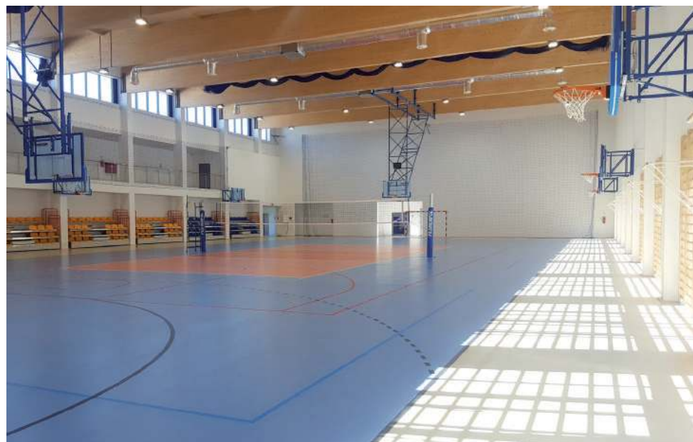
Fot. Wykonawca budowy - Kartel S.A.
