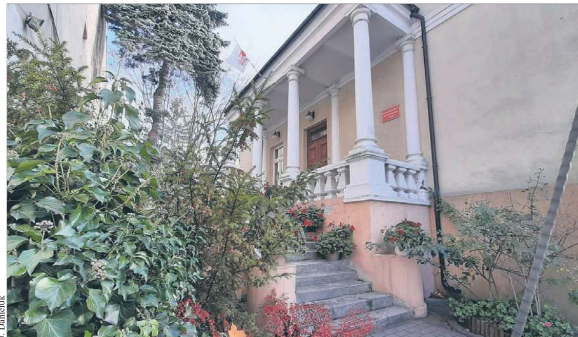
Przedszkole nr 1 ma być jednym ze zmodernizowanych obiektów
