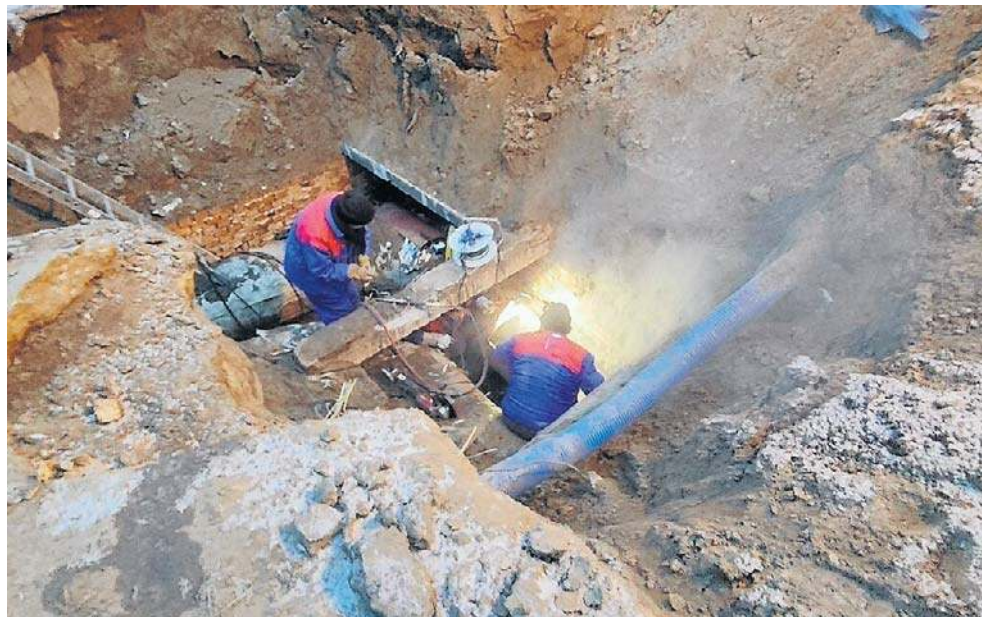
Ekipy remontowe MPEC pracowały nad usunięciem awarii
