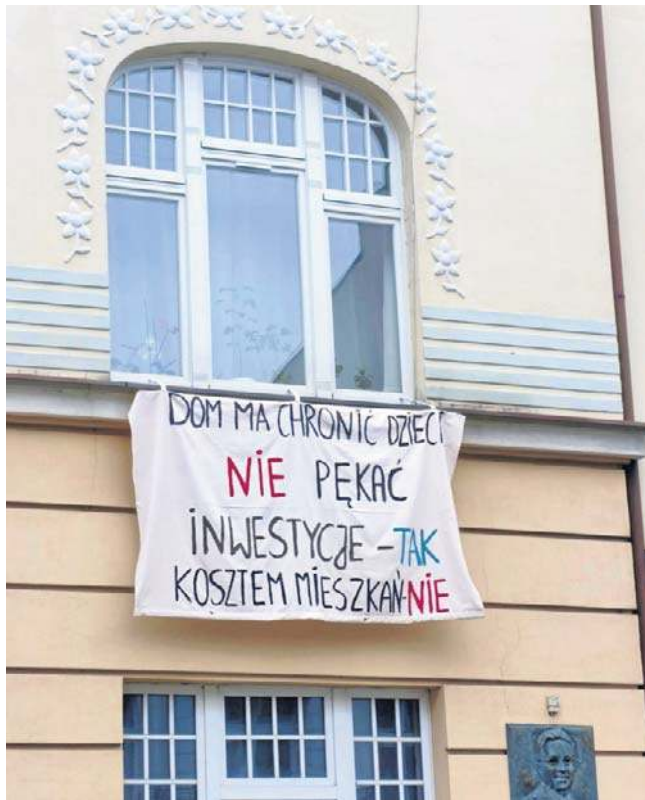
Prace na Wileńskiej 6 w Bydgoszczy mają potrwać do końca lutego
