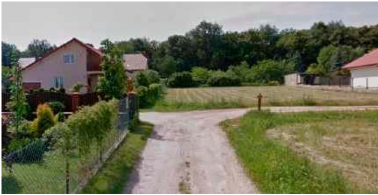
W tym roku projekt, a budowa ulicy z pełną infrastrukturą za rok. Tak życzyła sobie większość mieszkańców ul. Bażantowej i ulica została wykreślona z tegorocznego harmonogramu asfaltowania gruntówek
