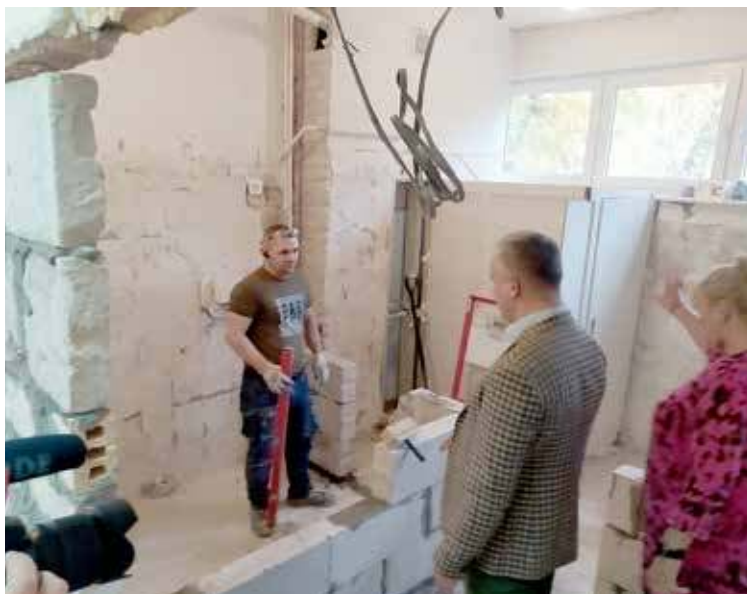
Gmina zapewniła wkład własny do modernizacji Biblioteki Miejskiej. Będzie to jedna z kilku inwestycji przechodzących, której zakończenie przewidziane jest w 2023 roku
