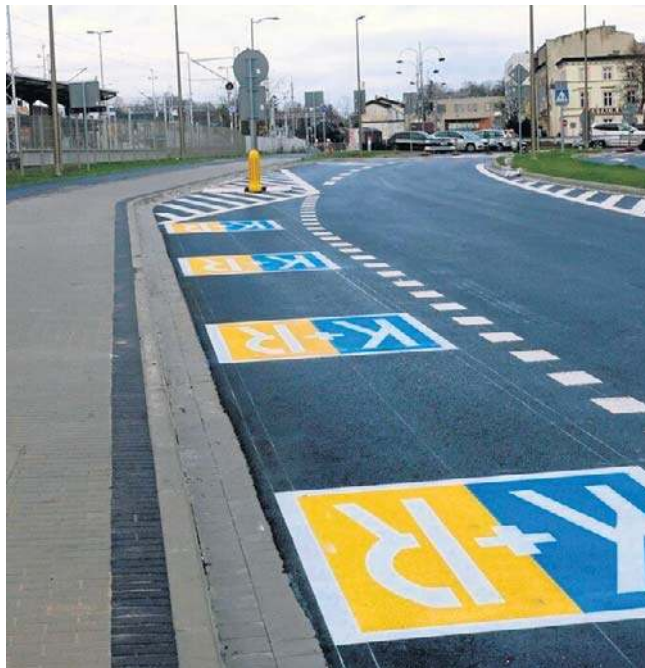
Jednocześnie przebudowano ulicę Kolejową
