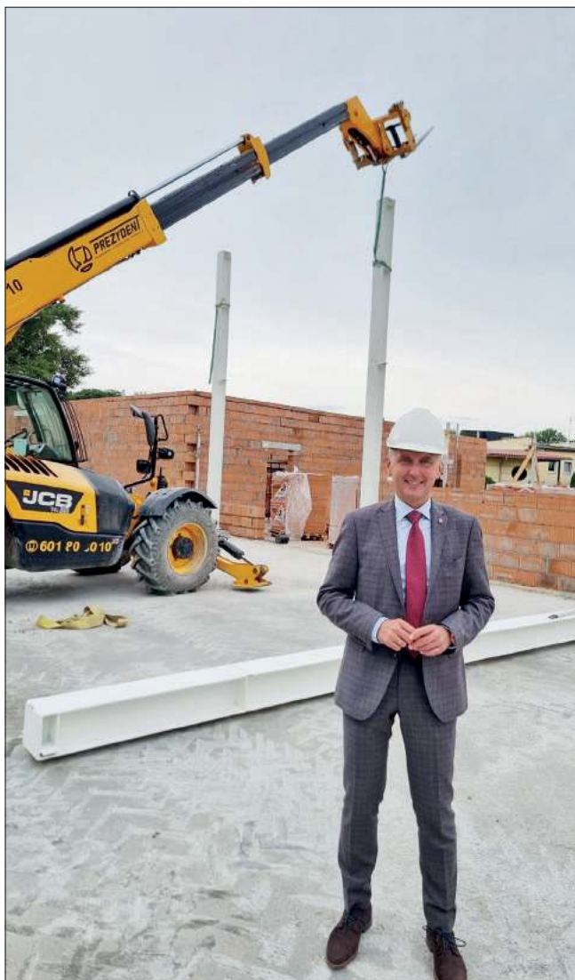
■ Prezydent Raciborza na placu budowy nowego lodowiska na Zamkowej
