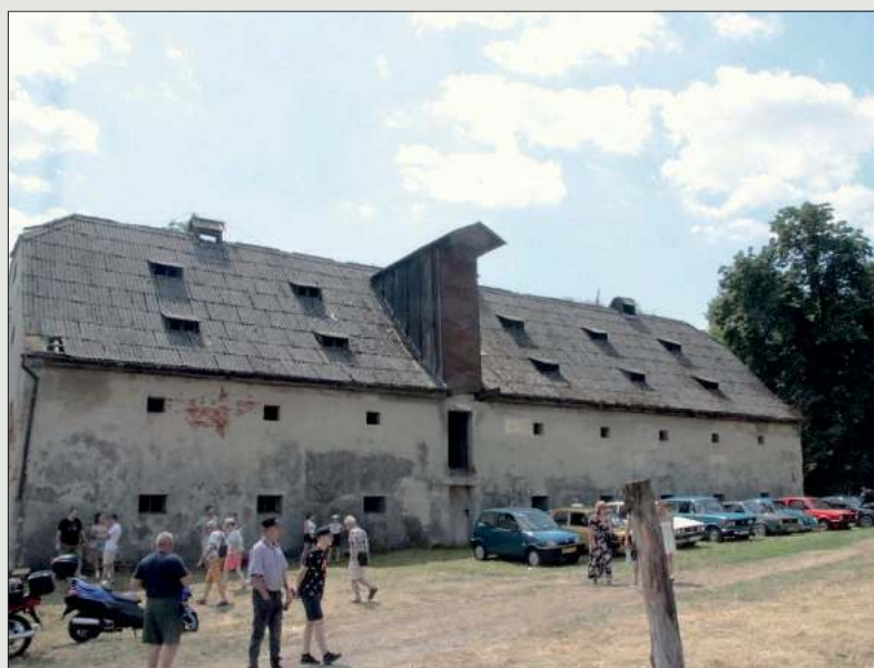
■ Spichlerz folwarczny jest najlepiej zachowaną budowlą wokół innych obiektów wchodzących w kompleks ruin pałacu w Sławikowie
