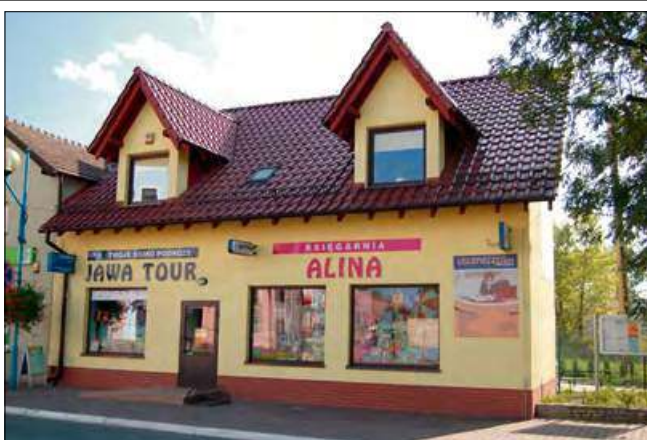
W miejsce baraczku powstała nowa siedziba biura.
