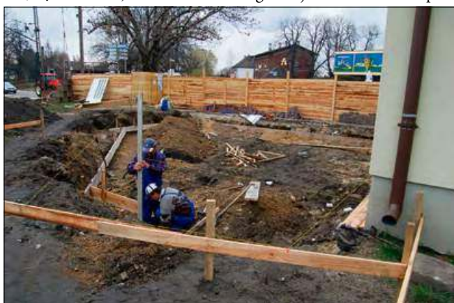
Wytyczanie granic nowego biura, budowa.
