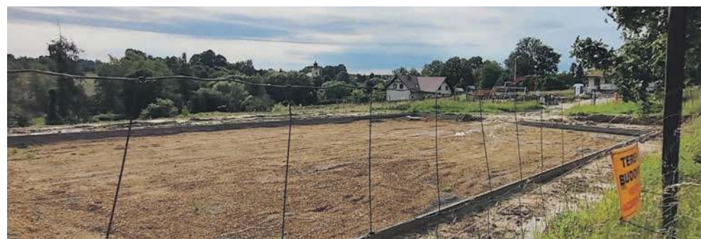
Budowa centrum rekreacyjnego w Porębie Żegoty
