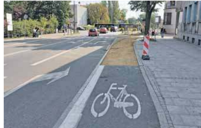
...a w ubiegłym tygodniu asfalt zerwano
