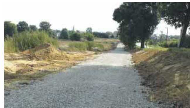
Trwa budowa ścieżki pieszo-rowerowej na ul. Staffa w Tarnowskich Górach
