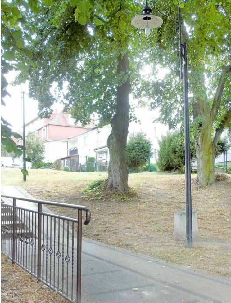
Budowa oświetlenia wzdłuż ścieżki dookoła jeziora jest jeszcze na bardzo wstępnym etapie
