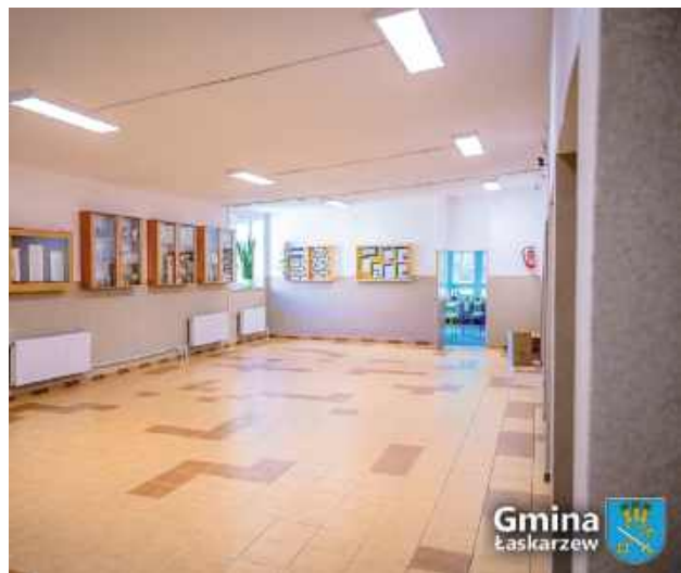
ok W hali wykonano gruntowny remont
