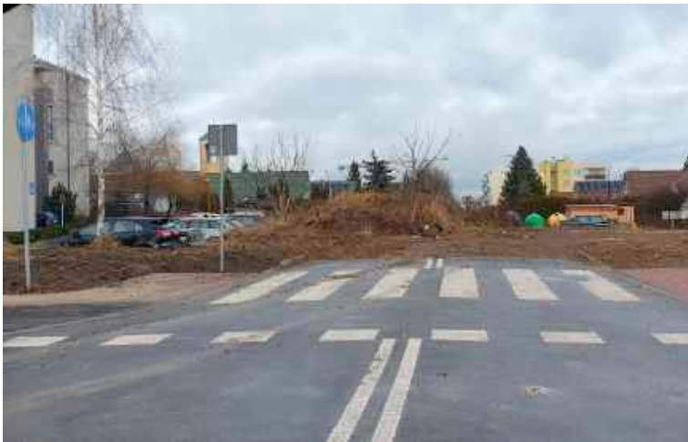
Mieszkańcy osiedla zlokalizowanego przy ul. Jaworowej zwrócili się z prośbą o uwzględnienie w tegorocznym budżecie miasta środków na budowę odcinka łączącego al. Solidarności bezpośrednio z ul. Jaworową
