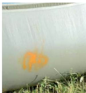
Ktoś pomazał zbiornik z wodą przy remizie
