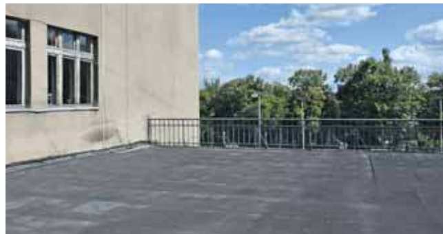
Po modernizacji będzie można korzystać z tarasu?
