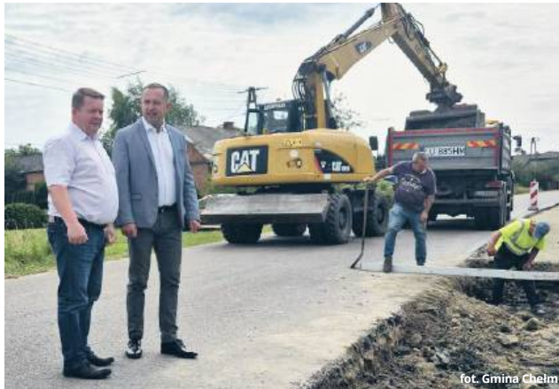
Prace drogowe w Horodyszczu
