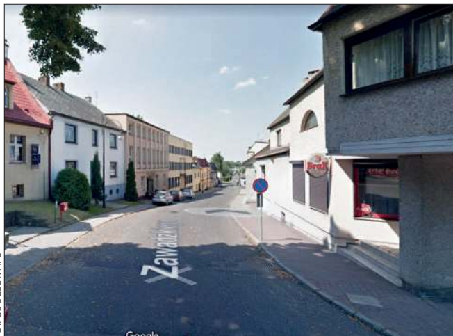
■ Zadanie rozpoczęło się od przebudowy ulicy Zawadzkiego
