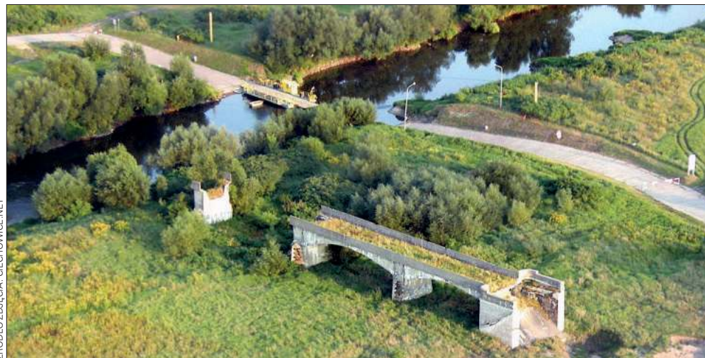
■ Pojawia się nadzieja na budowę nowego mostu. Według szacunków resortu infrastruktury przeprawa może powstać do 2027 roku. Korzystanie z promu dla miejscowych pozostanie więc jedynie wspomnieniem, choć może stać się atrakcją turystyczną.
