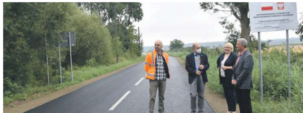
Przegląd wyremontowanej drogi nr 1544D, przebiegającej przez Biskupice Oławskie
