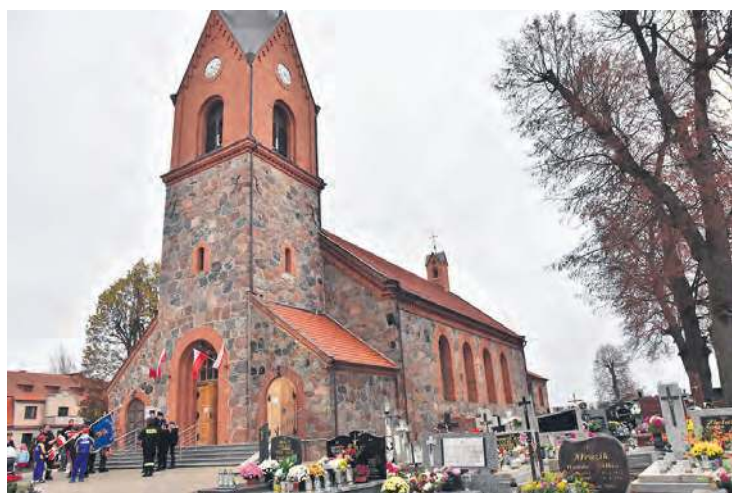
Prace konserwatorskie mają być prowadzone przy elewacji kościoła pw. św. Mikołaja w Lubiewie.
