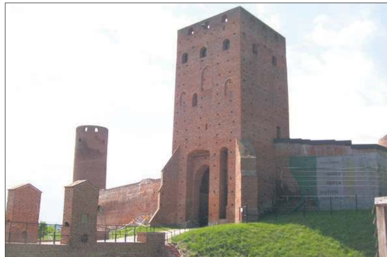
Zamek w Czersku – widok na most i wieżę bramną oraz fragmenty murów
