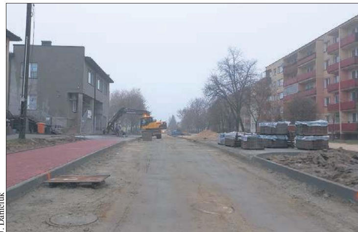
Przebudowa fragmentu ulicy Lasockiego
