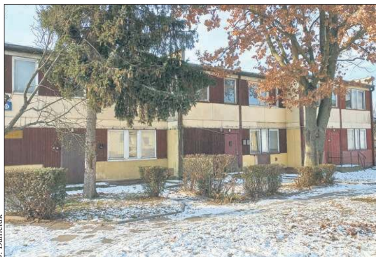
Czas na wyburzenie starego budynku i budowę nowego bloku przy ul. Miodowej 33
