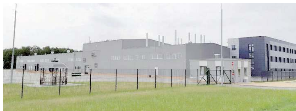
Fabryka akumulatorów ma opóźniony start
