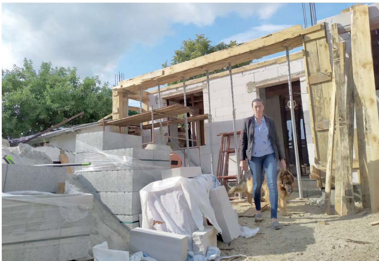
Trwa budowa nowego domu pani Anety i jej mamy. Na razie kobiety mieszkają kątem u rodziny
