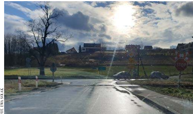
W rejonie skrzyżowania Daszyńskiego i Zwierzynieckiej w Tenczynku powstaną trzy przejścia dla pieszych
