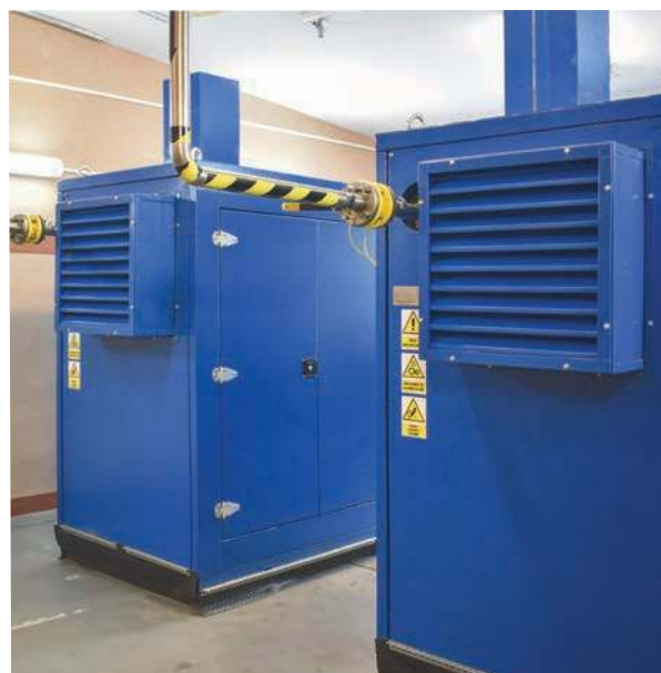
Agregaty kogeneracyjne na biogaz
