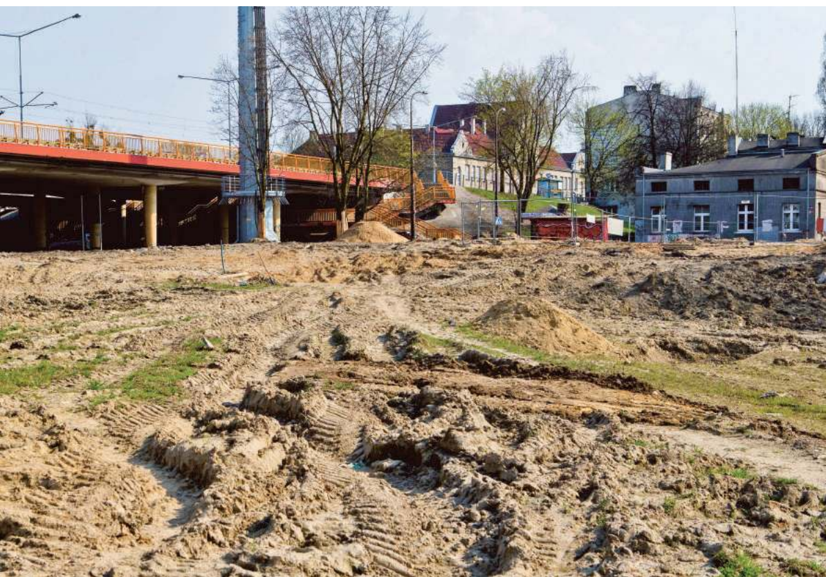
Budowa ul. Nowowęglowej przysparza mieszkańcom wielu kłopotów | fot. Jan Środa/Gazeta Polska
